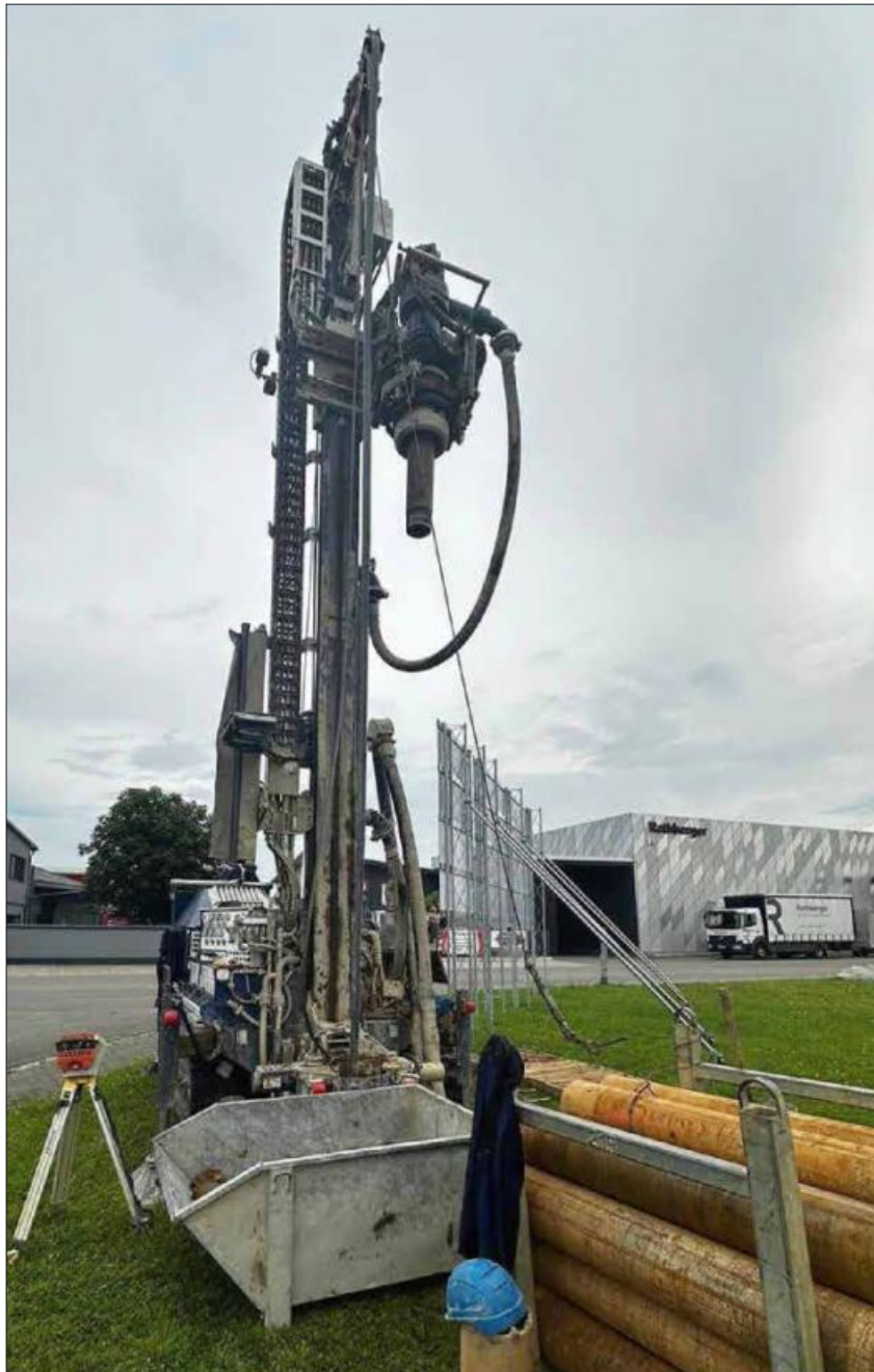
Der gigantische Bohrer dringt bis in eine Tiefe von 120 Meter vor.
