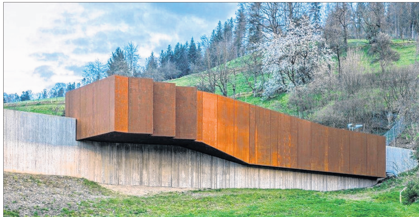
Die Stahlfassade für das Tunnelbetriebsgebäude in Waldkirch, das für den Staatspreis nominiert wurde, stammt von der Firma Rathberger in Efringen-Kirchen. Foto: Olaf Herzog
