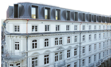
Freiburger Hof, Freiburg / Stehfalzdach
