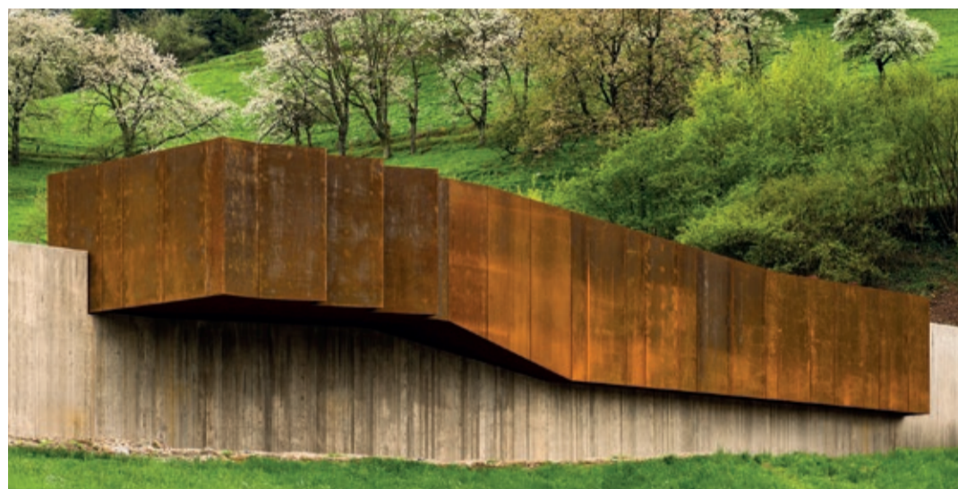
Technisches Betriebsgebäude Waldkirch
